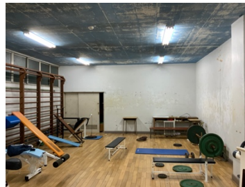
塗装前のトレーニング室
