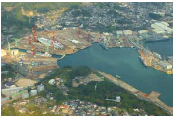
米軍艦船の修理にも取り組み、高い修繕能力を持つ佐世保重工業(SSK、佐世保市)のドックなど施設群
