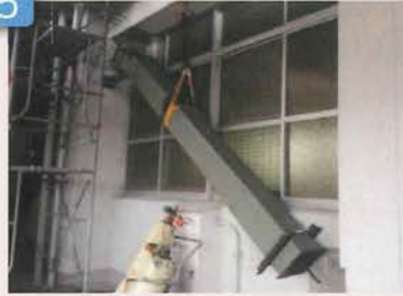
ブレース設置
