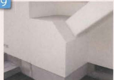
接合部・ブレース 仕上
