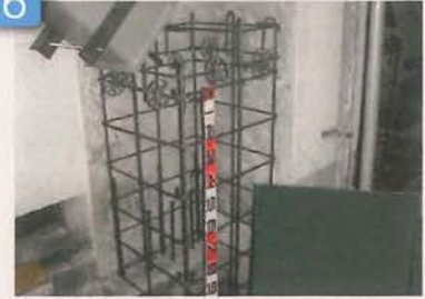
接合部 配筋工事
