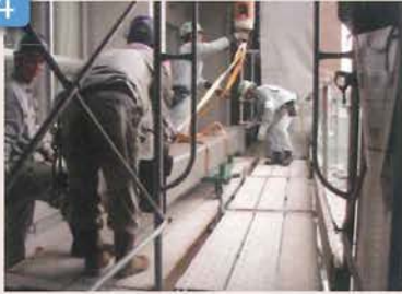
吊込み・人力による横持ち
