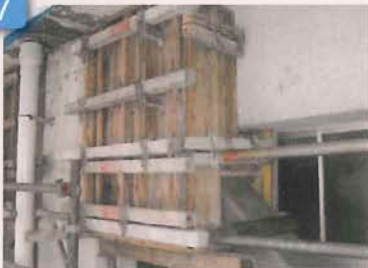
接合部 型枠工事
