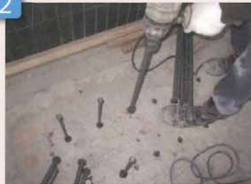
あと施工アンカー打設
