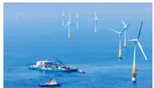
洋上風車 (提供: 戸田建設株)
