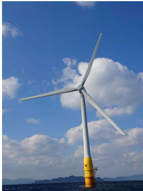
五島市沖の洋上風車『はえんかぜ』
