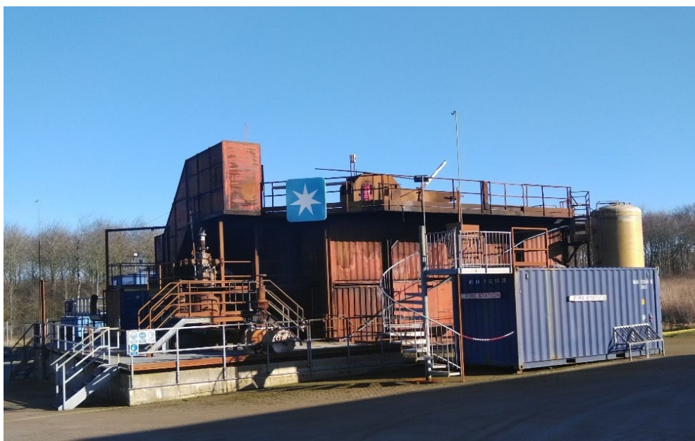
図 5 ガス油田における消火訓練施設
