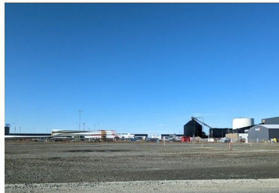
図 13 エスビアウ港に集約したブレード
